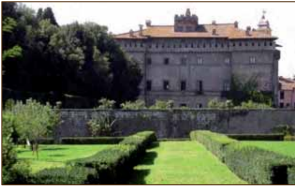
Palazzo Ruspoli lato giardino
