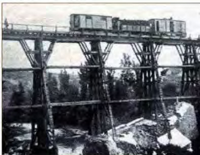
Ponte provvisorio in legno sul Treja.
